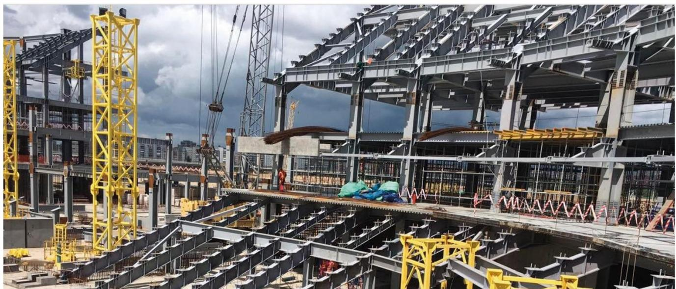
*Здания на основе металлоконструкций хорошо переносят перепады температур, не дают усадки и могут быть построены в сейсмоопасных зонах. Сборка здания может осуществляться в любое время года и в любых погодных условиях.*
