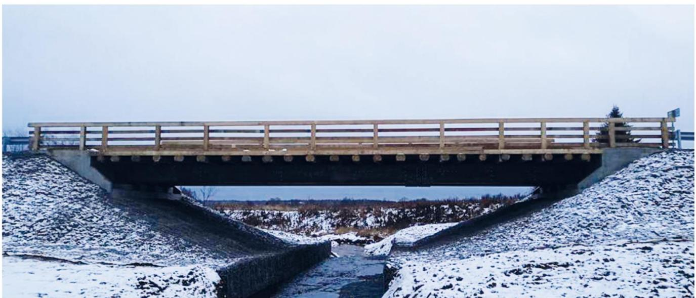
Стоимость производства мостов из данной стали без окраски ниже на 10-15% в сравнении с традиционными марками стали. Мосты из стали 14ХГНДЦ имеют низкие эксплуатационные издержки, а экономия затрат в жизненный цикл конструкций составляет до 30%.
