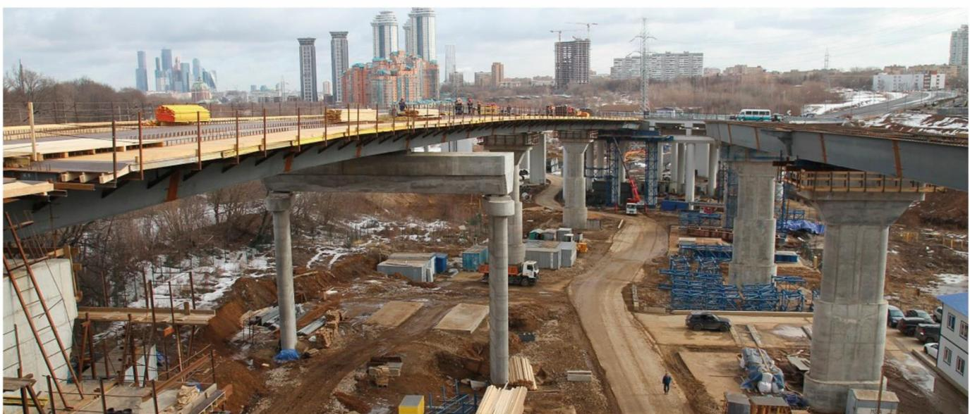
Все мостовые металлоконструкции изготавливаются в строгом соответствии с требованиями, предъявляемыми к конструкциям данного типа. При изготовлении конструкций используется металлопрокат следующих марок: 10ХСНД, 15ХСНД, 14Г2АФ, 09Г2С.
