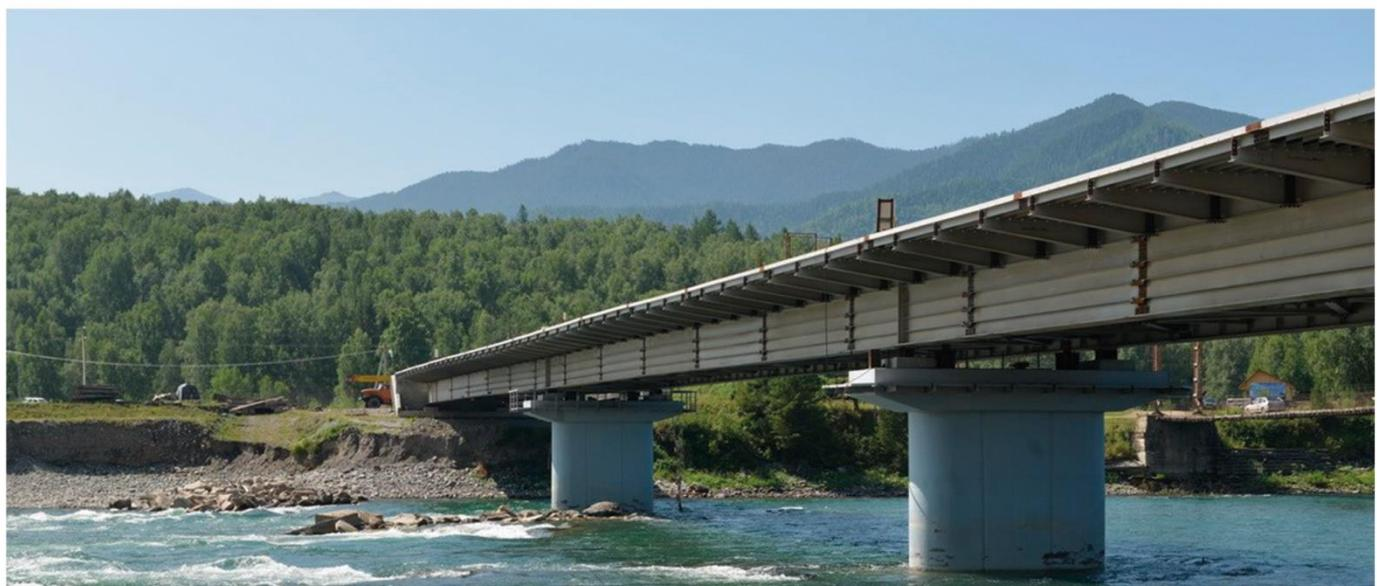
Для изготовления мостовых конструкций, эксплуатируемых в регионах Крайнего Севера, Тульский металлопрокатный завод применяет специальные марки стали с повышенной ударной вязкостью и устойчивые к низким температурам.
