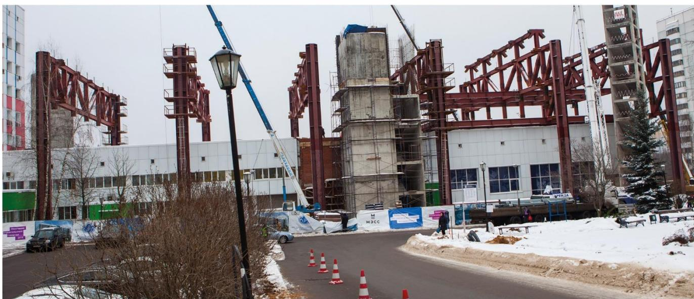
Выгодным преимуществом зданий из металлоконструкций являются стальные балки. Они дают возможность перекрывать пролеты до 18 метров, что в свою очередь позволяет освободить внутреннее пространство здания от колонн и обеспечить полную свободу планировки помещений.
