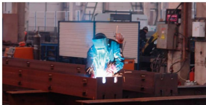
СБОРКА И СВАРКА
